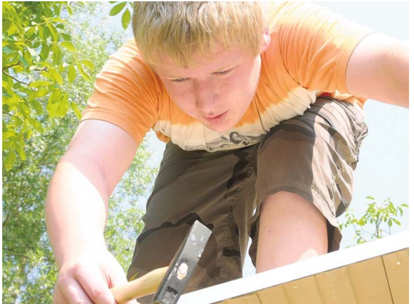
Schweißtreibende Arbeit auf dem Dach des Pavillons, den die Schüler der Haupt- und Werkrealschule am Bildungszentrum gebaut haben. Er soll zur „Schulrevue“ eingeweiht werden. Hier nagelt der 14-jährige Joachim Eppler eine Plane aufs Dach des Pavillons.
